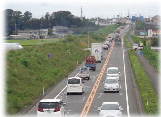
国道50号線 小林付近
