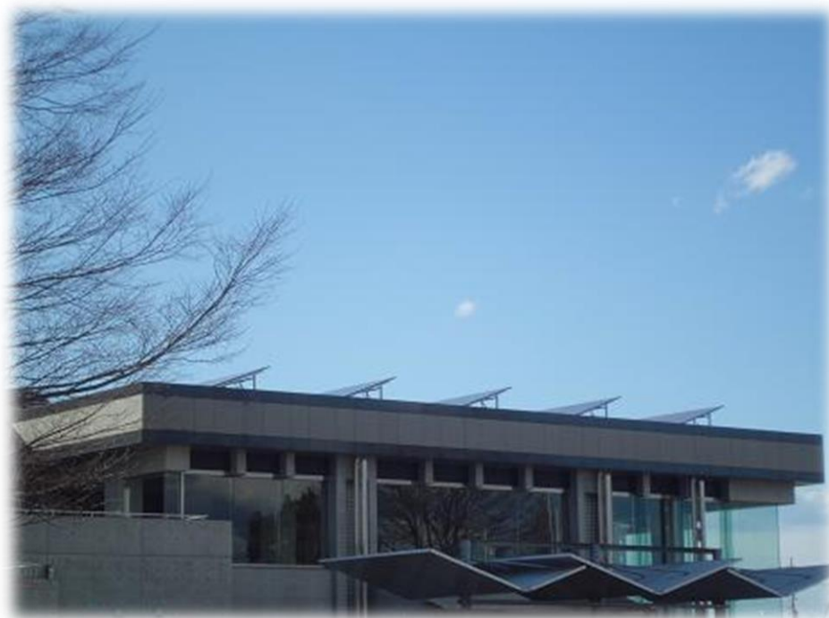
下館体育館：太陽光発電システム
